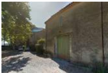
La grange de Verny Source : crédit photo : GoogleStreetView
