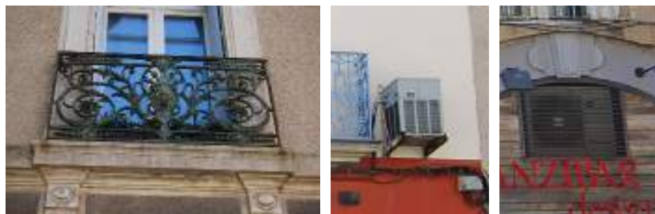
Des éléments en façade plus ou moins soignés Source : crédit photo Urban Projects
