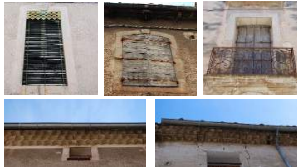
Des éléments d'architecture à maintenir : stores et lambrequins, encadrements, volet à lame horizontale, garde-corps en fer forgé, génoise... Source : crédit photo Urban Projects
