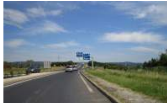
Séquence d'entrée depuis l'autoroute
