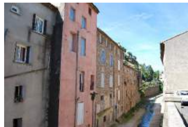
Un tissu bâti dense qui laisse peu de place à la végétation Source : crédit photo Urban Projects
