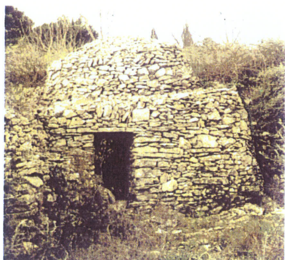
Une capitelle : petit joyau de pierres sèches servant d'abri pour les bergers.
